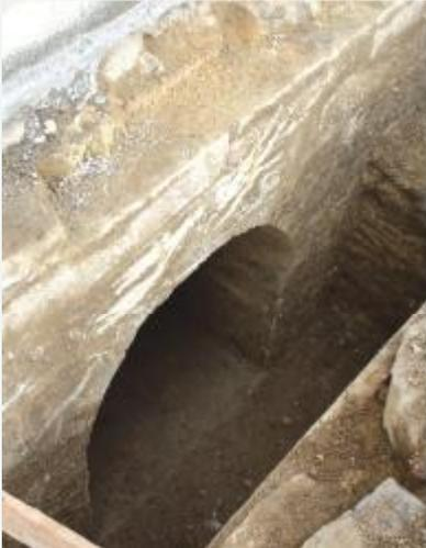
Die Arbeiten wurden mit einer denkmalgerechten Abdichtung der Fundamente bis 1m Tiefe mit Derton abgeschlossen, um das Eindringen von Feuchtigkeit aus dem umgebenden Erdreich zu verringern. Derton ist eine nur aus Mineralien bestehende Tonmischung, die dauerhaft sogar gegen drückendes Wasser abdichtet. Entscheidender Vorteil ist neben der Materialverträglichkeit jedoch die Möglichkeit, klüftige Fundamente ohne Glättung der Oberfläche abdichten zu können.
